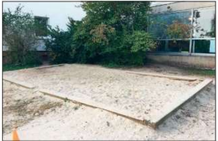
Der Sandspielbereich vor der Erneuerung.
