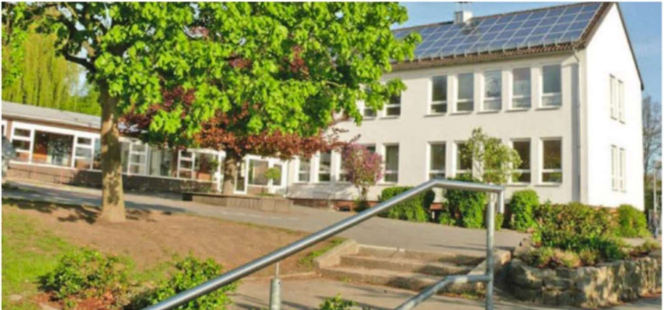
Die Grundschule lädt zum Schulfest ein. Auf dem Dach des Schulgebäudes produzieren Solarzellen Strom.
