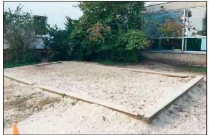
Der Sandspielbereich vor der Erneuerung.
